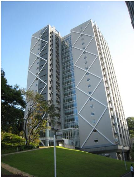
図 4-31 高密度観測を行っている超高層免震建物 (J2-J3 棟、すずかけ台キャンパス)
