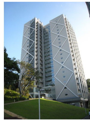
図 4-40 高密度観測を行っている超高層免震建物（J2-3 棟、横浜キャンパス）
