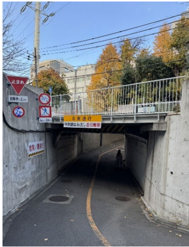
図 4-34 キャンパス内の構造物 (石川台トンネル：上面は橋梁となっている)
