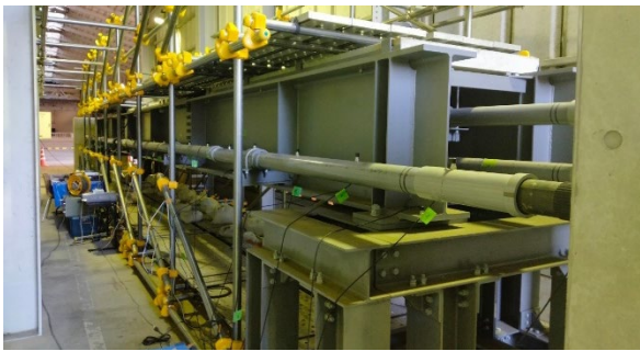
図 4-39 模擬橋梁を用いた光ファイバによる振動計測実験（共同研究）
