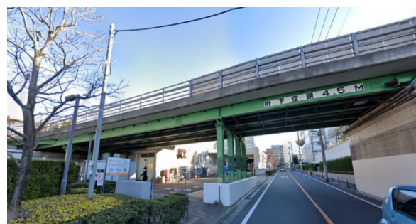
図 4-32 キャンパス内の橋梁（富士見橋）
