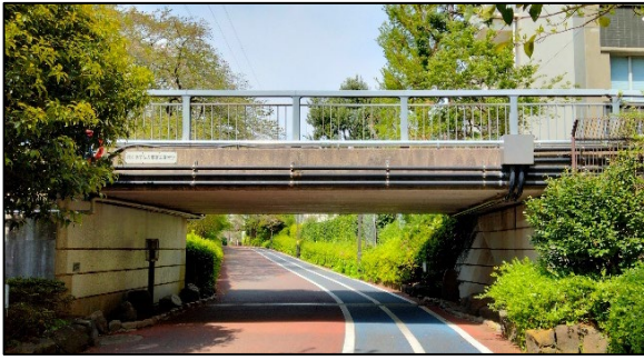
図 4-33 キャンパス内の橋梁（轟橋）
