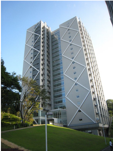
図 4-28 高密度観測を行っている超高層免震建物 (J2-3 棟, すずかけ台キャンパス)
